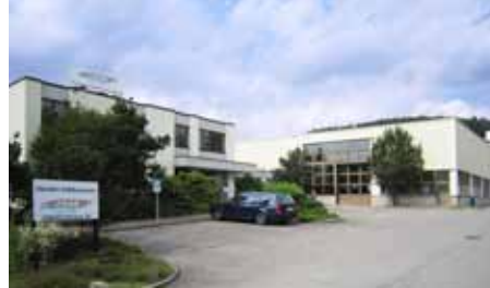
Swiss Logistics Academy AG Ausbildungszentrum Industriestrasse 36 CH-8112 Otelfingen /ZH Telefon 044 847 46 45 / Fax 044 847 46 88 kursadministration@sulsergroup.ch
