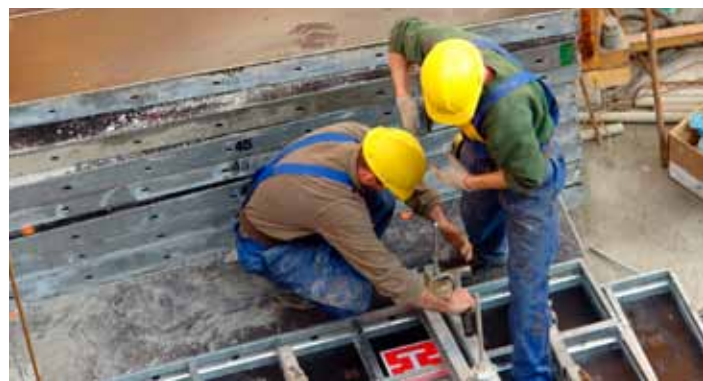
Im Modul «Versetzarbeiten» (½ Tage) erlernen die Teilnehmer das fachgerechte Versetzen eines Kantenschutzes.
