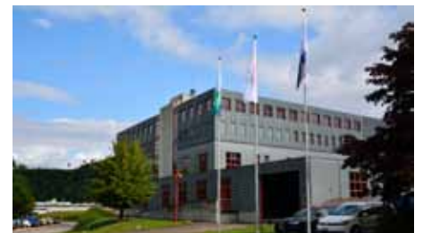
Sulser Logistics Solutions AG Logistickenter und Ausbildungszentrum Bubendorf Grünenstrasse 37 CH-4416 Bubendorf / BL Telefon 061 466 40 00 / Fax 061 466 40 09 info@sulsergroup.ch
