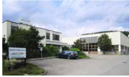
Swiss Logistics Academy AG Ausbildungszentrum Industriestrasse 36 CH-8112 Otelfingen / ZH Telefon 044 847 46 45 / Fax 044 847 46 88 kursadministration@sulsergroup.ch
